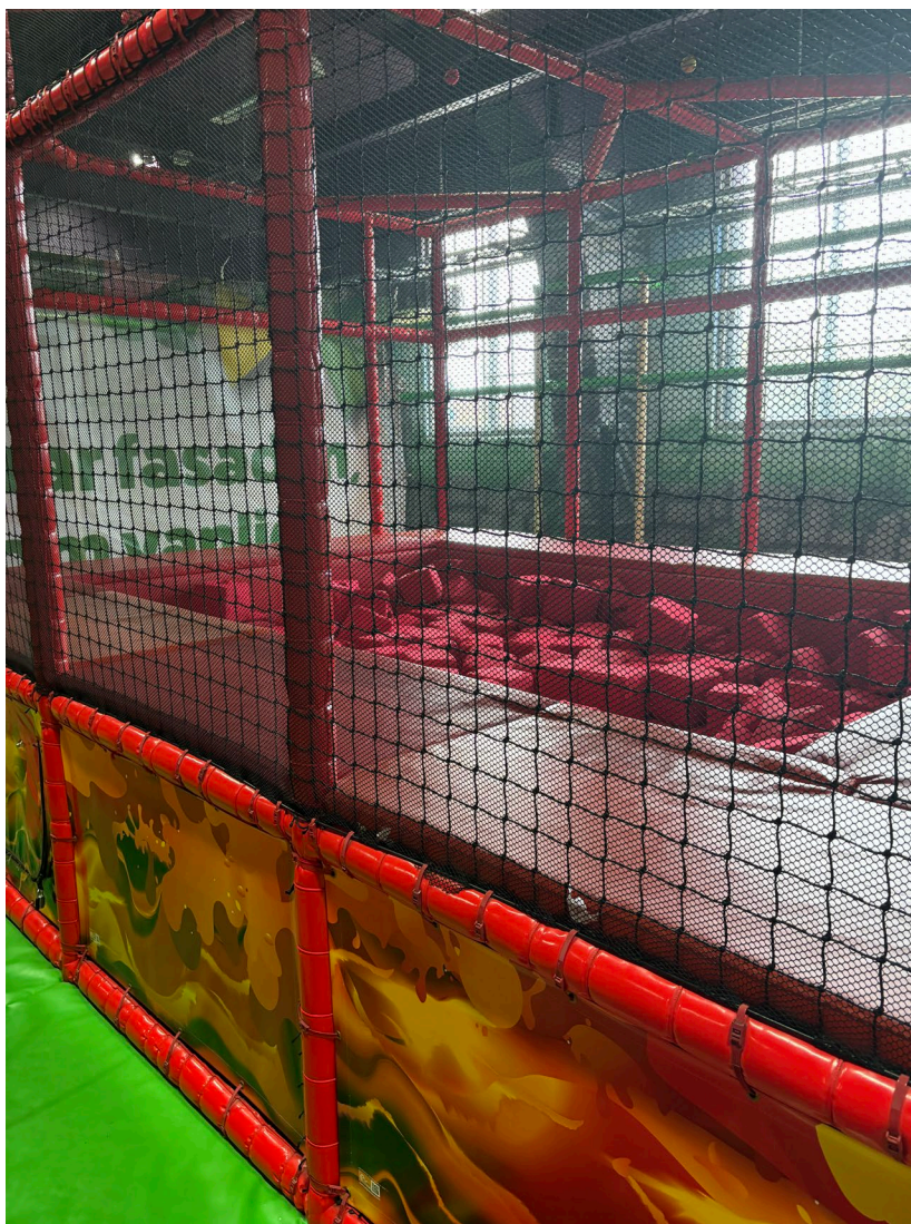
En skumgrop på ett av de kontrollerade leklanden som inte uppfyller kraven på dämpning och skumdjup.
