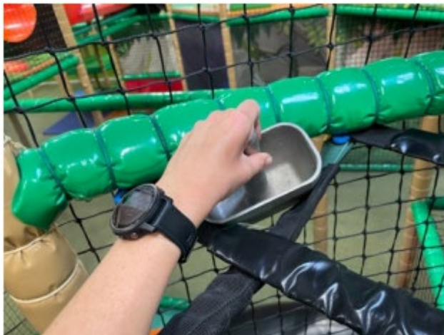
Öppning i ett nättorn där barn kan komma igenom med kroppen men inte med huvudet och riskera att bli hängda. Konstruktionsfel.
