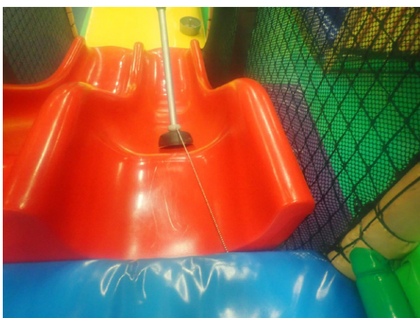
Bild 5. Glipa vid startdelen på rustchbana där en snodd på en huvtröja kan fastna och riskera att barn som åker ned blir hängande och stryps.
