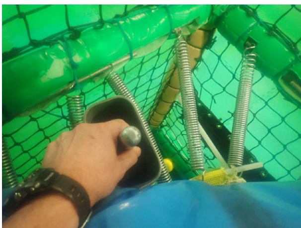
Bild 8. Lösa kantskydd som medför risk för att barn kan komma ned med kroppen och fastna i huvud/hals mellan fjädrar.
