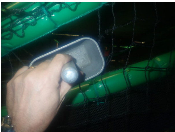
Bild 17. Exempel på påträffade underhållsbrister.
